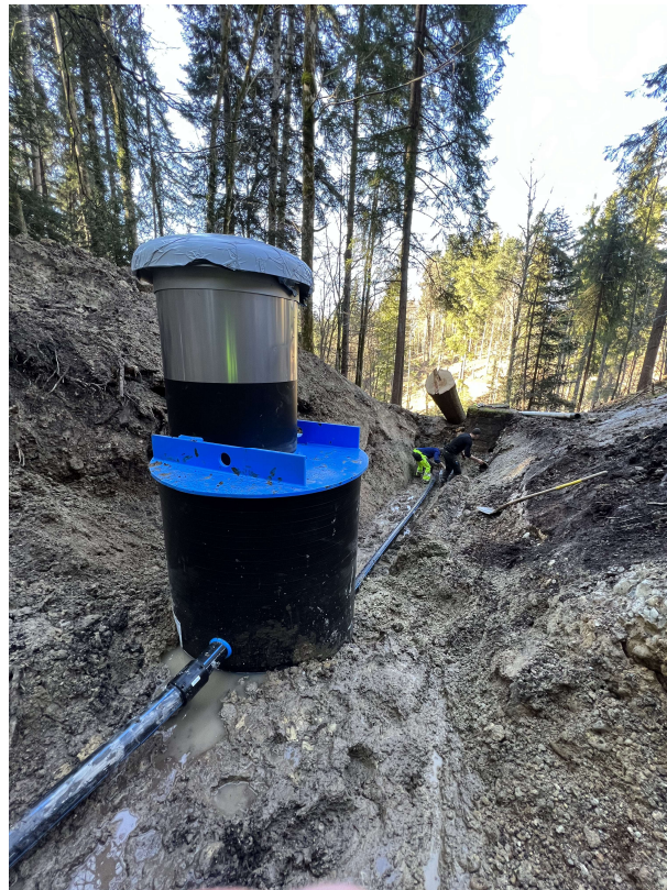
«Neuer Quellschacht 126 im Fassungsgebiet Tobelmühle»
